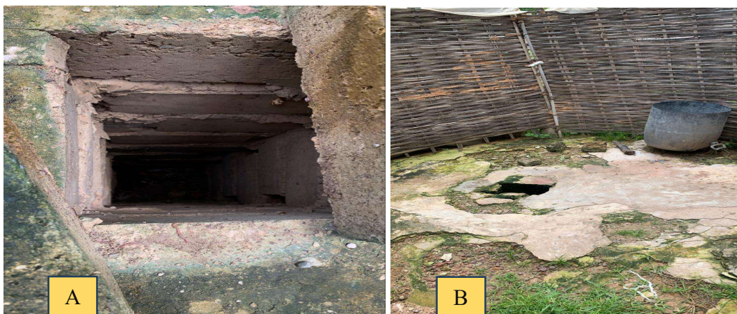
Planche photographique 2 : fosse perdue (A) et latrines traditionnelles (B) au quartier Hiléle de Kolda (cliché : Diallo 2025)
